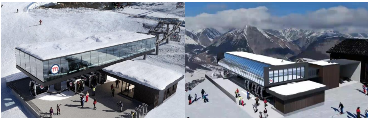
Abbildung 22 & 23: Livigno-Mottolino Seilbahnanlage mit Mittelstation (© SIMICO S.p.A. 1 & 2)
